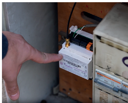
Installation d'une horloge connectée dans une armoire électrique dédiée à l'éclairage public
