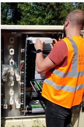
Les travaux de distribution consistent à déployer des câbles depuis le SRO jusqu'à des boîtiers appelés Points de Branchement Optique (PBO). Ce sont ces boîtiers qui permettent dans un second temps la réalisation des raccordements abonnés.
