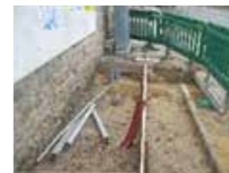
Gabarit de la dalle
