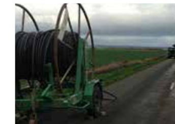
Réalisation du lien entre le central téléphonique et l'armoire de montée en débit
