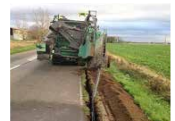
Pose de fourreaux en micro-tranchée
