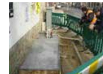
Coulage de la dalle
