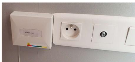
La première étape lors de l'arrivée des techniciens consiste à définir l'emplacement précis de l'arrivée de la fibre optique. Il est important d'y réfléchir en amont du rendez-vous pour bien adapter cette position au logement. En effet, le boîtier fibre installé dans l'habitation qui est nommé PTO pour Prise Terminale Optique ne peut plus être déplacé par la suite et son positionnement doit être définitif.
