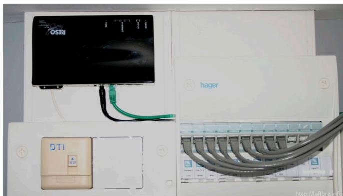
**Explication** : Le tableau de communication ainsi conçu permet d'accueillir tous les réseaux disponibles à l'entrée du logement et répond aux besoins en termes d'espace et d'alimentation électrique, pour accueillir sans travaux additionnels, les équipements actifs nécessaires au bon fonctionnement de ces réseaux.
